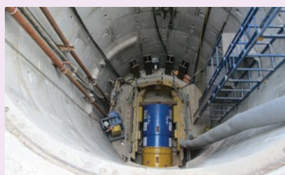
▲ Mini TBM in shaft
