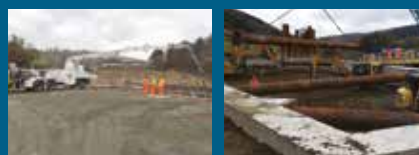
▲ Concrete pump for Ring Beam pour
